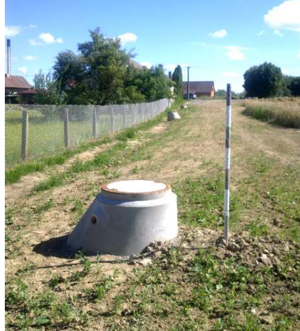
úsek s novou kanalizací ve Chmelišti
